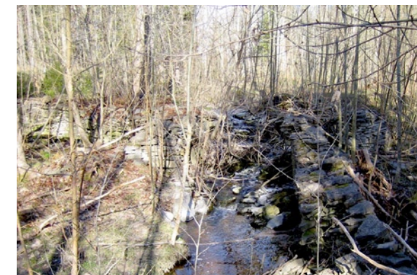
Magnuse såg. Dammanläggning.
